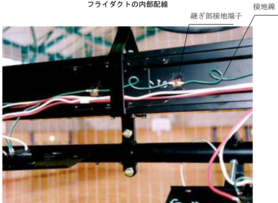
フライダクトの継ぎ部
