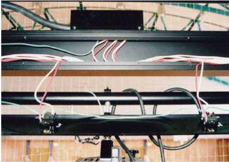
フライダクトの内部配線
