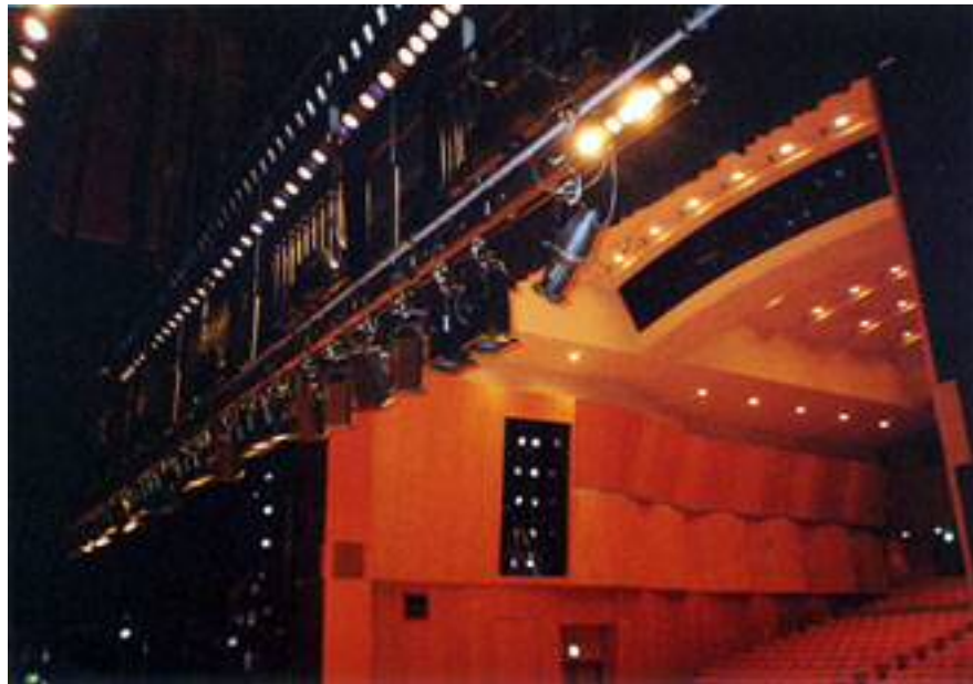
写真-5 舞台上の照明器具をアップした状態
