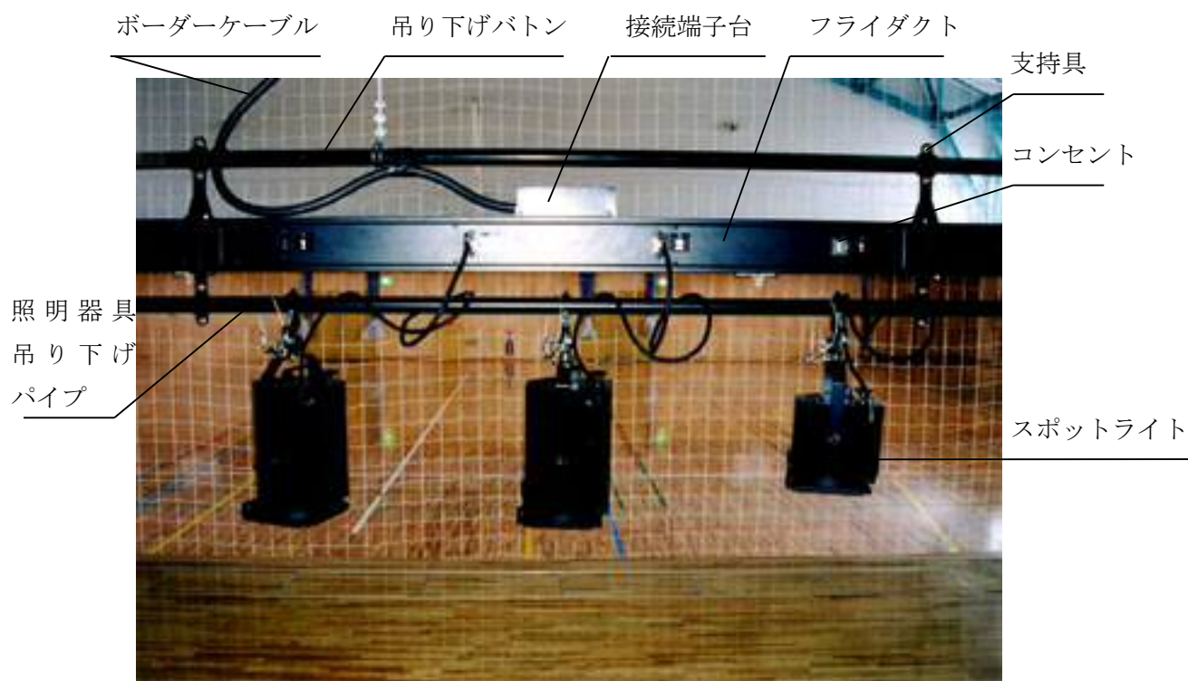
フライダクト外観
