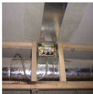
壁中継ボックス (電源接続)
